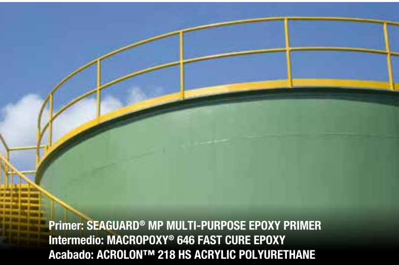
Primer: SEAGUARD® MP MULTI-PURPOSE EPOXY PRIMER Intermedio: MACROPOXY® 646 FAST CURE EPOXY Acabado: ACROLON™ 218 HS ACRYLIC POLYURETHANE
